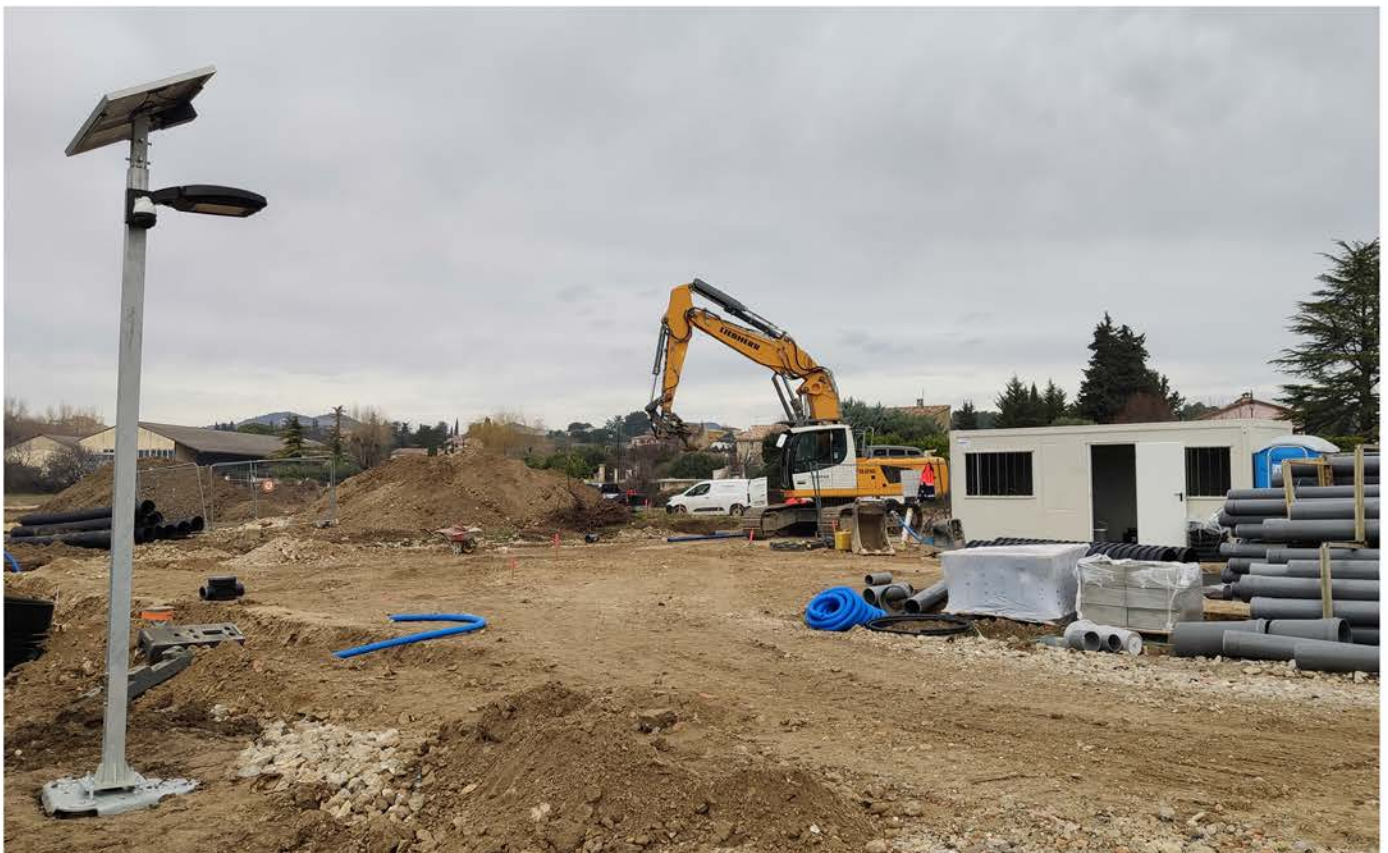
Caromb, Vaucluse (84), Sécurisation chantier
